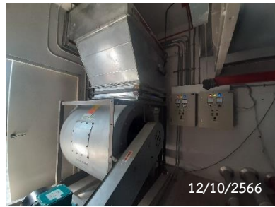
ภาพที่ 2.2-11 ระบบระบายอากาศของโครงการ
