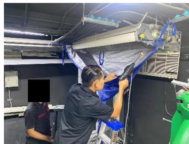
ภาพที่ 2.2-15 การทำความสะอาดเครื่องปรับอากาศ
