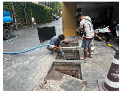
การสูบล้างก่อนจากระบบบำบัดน้ำเสีย ภาพที่ 2.2-5 ระบบบำบัดน้ำเสีย
