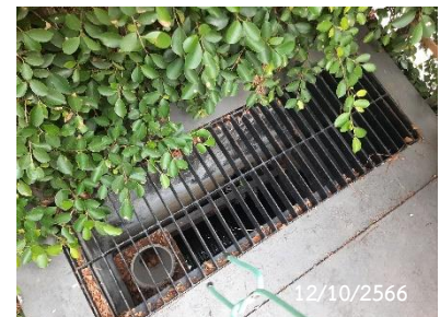
ตะแกรงดักขยะในท่อระบายน้ำ
